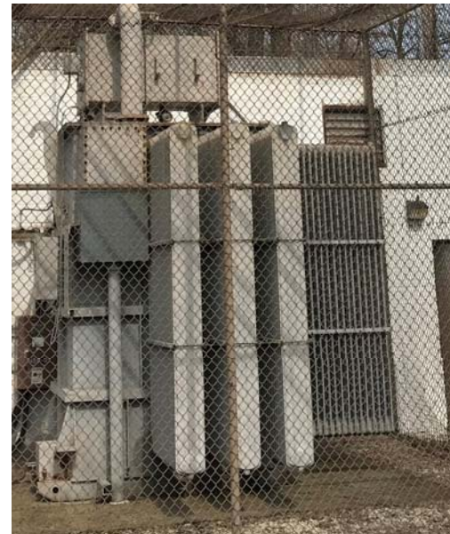
Existing Rectifier Transformer
