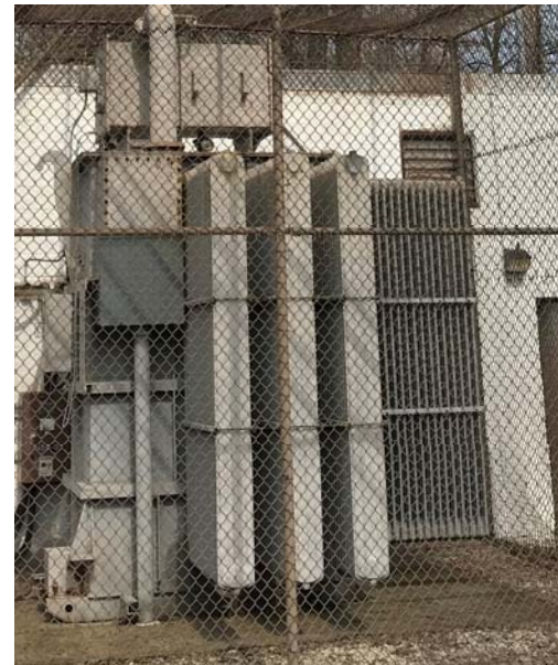
Existing Rectifier Transformer
